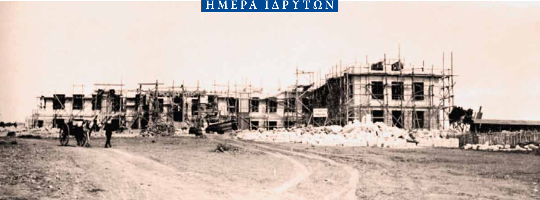
Το Μπενάκειο υπό κατασκευή το 1928
